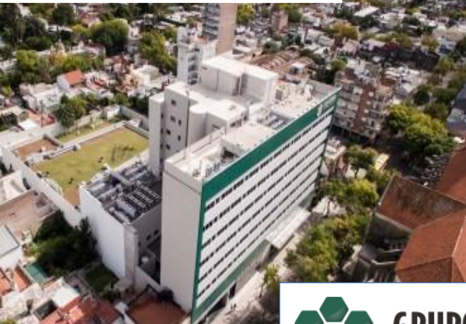
Hospital Privado de Rosario
